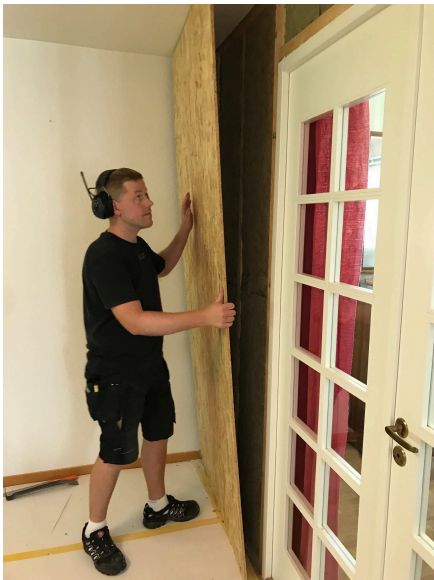
Robert från Hantverksdesign är noggrann med alla mått så OSB plattorna passar perfekt
